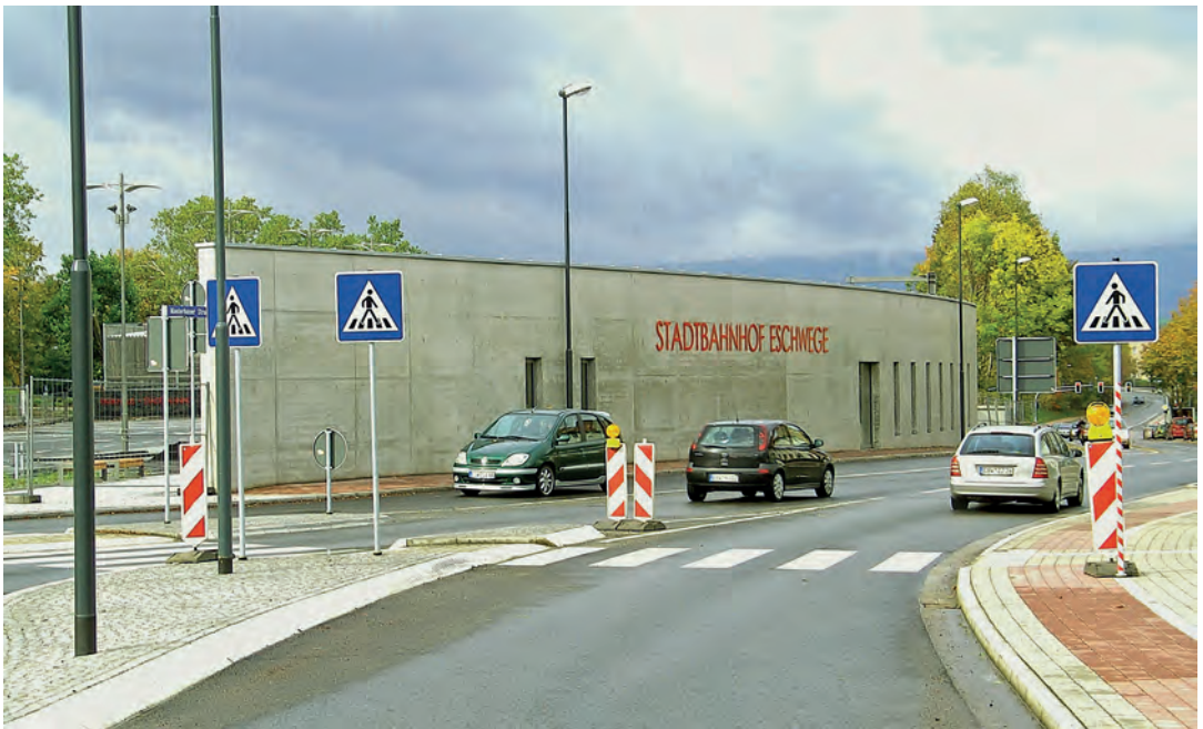
Abb. 37: Die fertige Fassade von der Straßenseite des neuen Stadtbahnhofs, 11. Oktober 2009.
