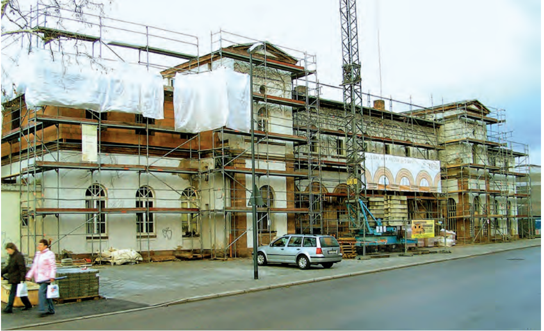
Abb. 36: Das ehemalige Empfangsgebäude während der Aufstockung des linken Traktes und Renovierung am 12. Dezember 2009.
