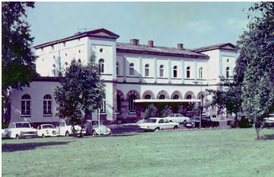
Abb. 32: Das für den Hessentag in Eschwege 1971 neu gestrichene Empfangsgebäude von der Straßenseite.
