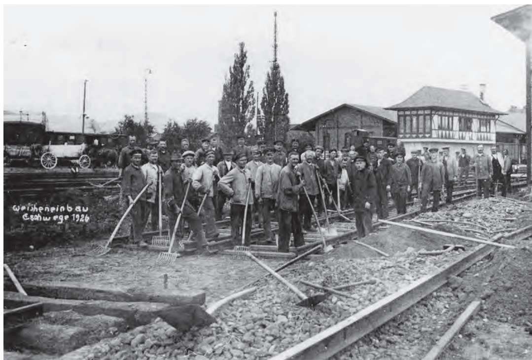
Abb. 18: Gleisarbeiten vor dem Fahrdienstleiterstellwerk „Em“ im Jahre 1926. Das Stellwerk wurde im Jahre 1956 abgerissen.
