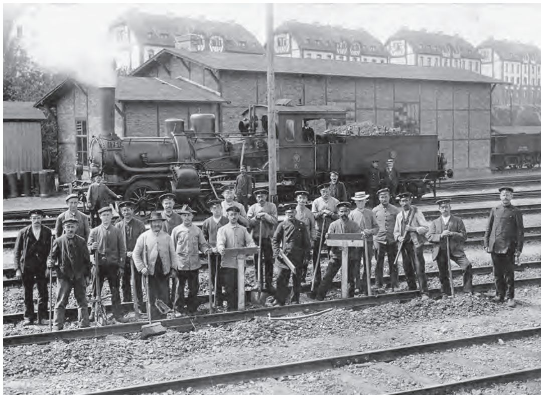
Abb. 10: Das Foto von den Gleisbauarbeiten am Treffurter Schuppen im Jahre 1912 ohne Sprung in der Glasplatte in bester Qualität.
