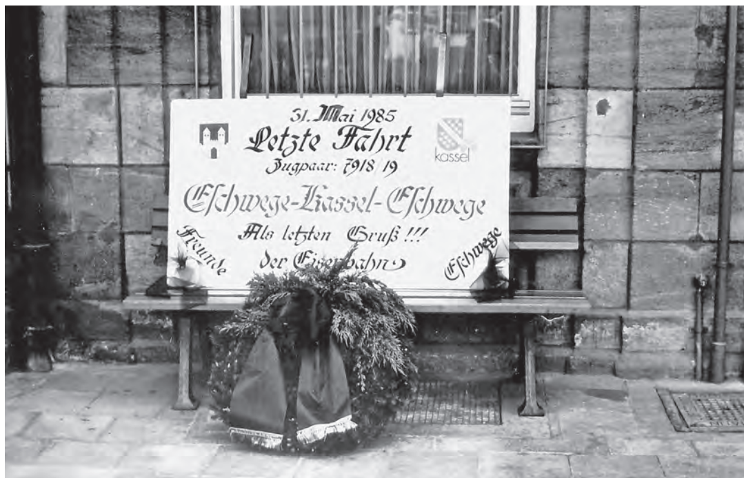
Abb. 34: Ein letzter Gruß von den Freunden der Eisenbahn am 31. Mai 1985, dem Ende des Personenverkehrs am Bahnhof Eschwege.
