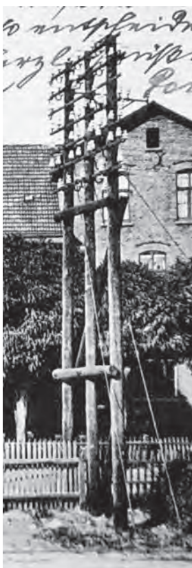
Abb. 8: Die neuen Doppelgestänge von den Telegrafmasten
