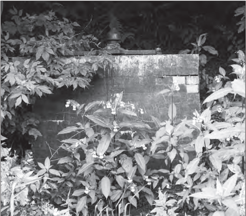
In diesem fast überwucherten Bauwerk am Waldrand ist der Queneborn heute gefasst, August 2008.
