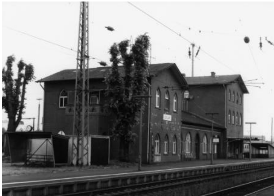
Abb. 5: Im Zusammenhang mit dem Bau der Berlin-Wetzlarer Bahn bekam der Bahnhof Lollar ein neues Empfangsgebäude in Insellage (Aufnahme Münzer, 2000)
