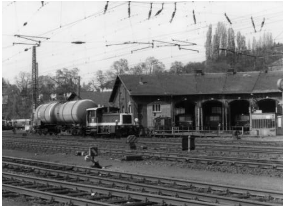
Abb. 4: Dieser Teil des Marburger Lokomotivschuppens wurde in den 1870er Jahren erbaut (Aufnahme Münzer, 1989)
