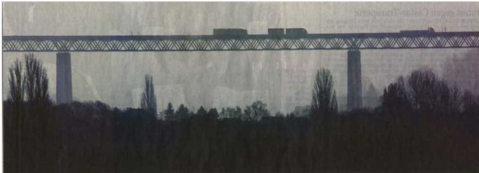
Abbildung 5: Die Autobahn-Brücke bei Bergshausen
