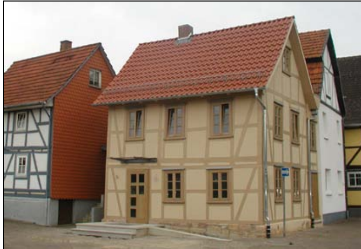
Abb.1: Foto des restaurierten Gebäudes Brauhausstraße 2
