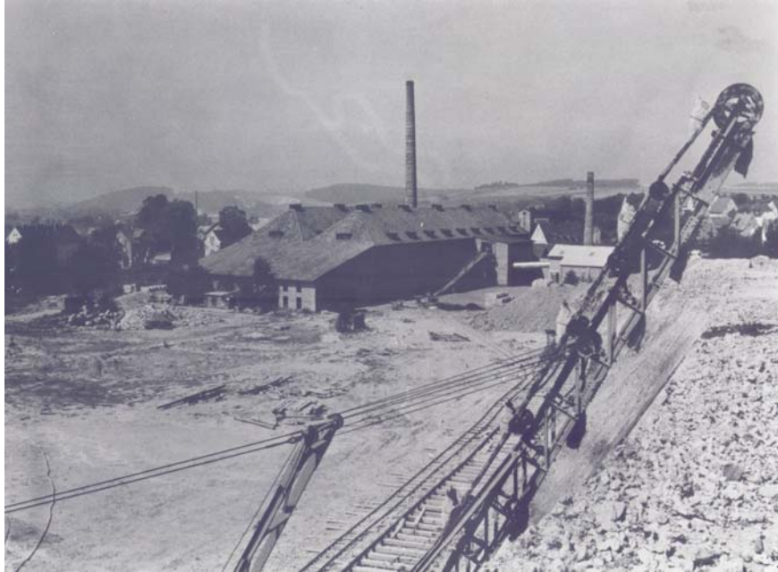
Abb. 3: Hauptgebäude der Oberkaufunger Ziegelei vom Tagebau aus mit dem Eimerkettenbagger im Vordergrund, Aufnahme 1960er Jahre
