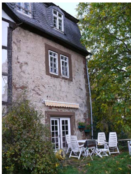
Abb. 5: Alter Flügel des Adelssitzes in Amönau mit Bausubstanz vom Beginn des 17. Jahrhunderts. Das noch gotische Untergeschoss mit Resten der Küche ist aufgefüllt. Im Obergeschoss sind die Fenster der Westseite des nach dem Parkettmuster bezeichneten so genannten Sternzimmers zu sehen. In diesem Raum von 3,15 m Höhe und rund 45 Quadratmetern Grundfläche hätte die Schlossorgel ohne Weiteres Platz gefunden
