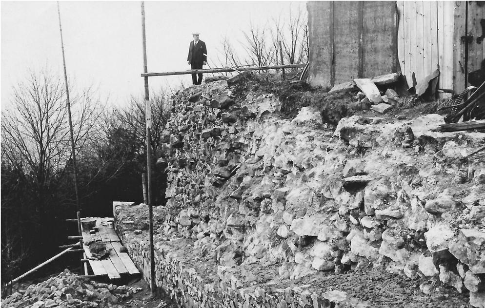
Abb. 11: Hochziehen der neuen Mauerschale am noch massiv erhaltenen Bastionskernmauerwerk, 1. April 1939 [Foto: Burgberggemeinde Homberg]
