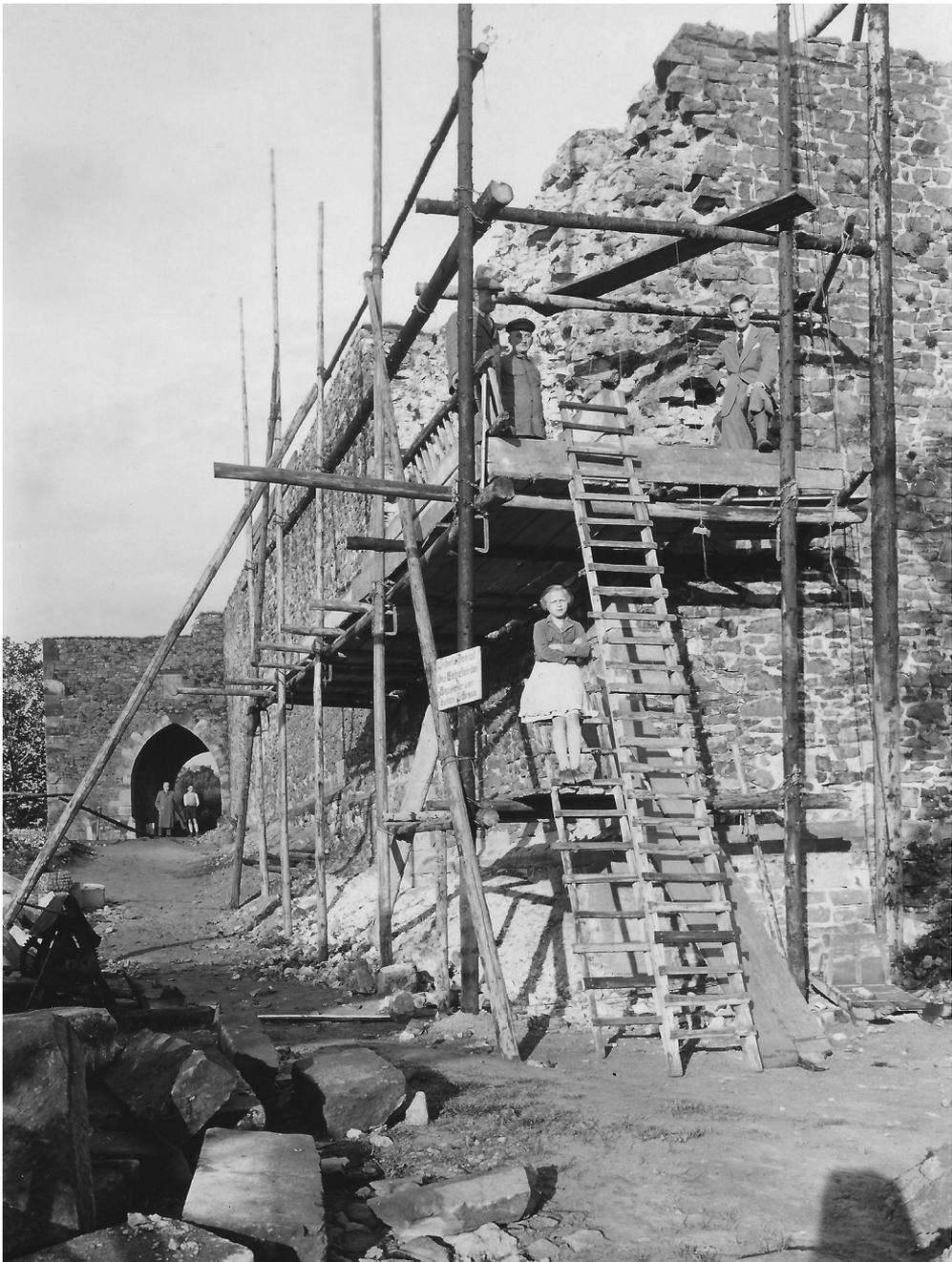
Abb. 6: Die Ecke der Palasmauer zur Vorburg wird wiederhergestellt, 6. Juli 1938. Man kann noch die Reste des Kernmauerwerks und im Hintergrund das fertig gestellte Tor erkennen. [Foto: Burgberggemeinde Homberg]
