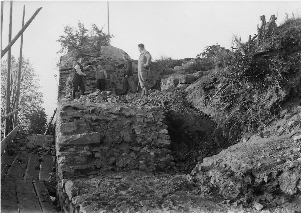
Abb. 4: Hochführen der bereits freigelegten Südmauer der Kernburg. Original
