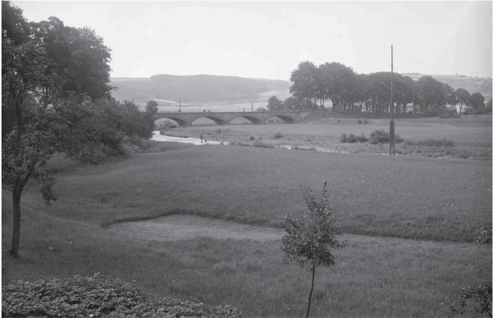
Abb. 11: Die Brücke mit dem von der Ortslage Cölbe führenden Damm, in einem Winter vor dem Zweiten Weltkrieg, aufgenommen von Südwesten, etwa aus der Nähe des Wohnplatzes Kupferschmiede [Foto über Gemeinde Cölbe]
