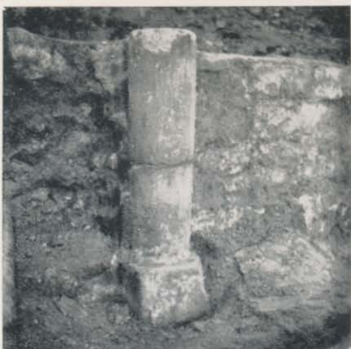
7. Wandpfeiler (E) im N
