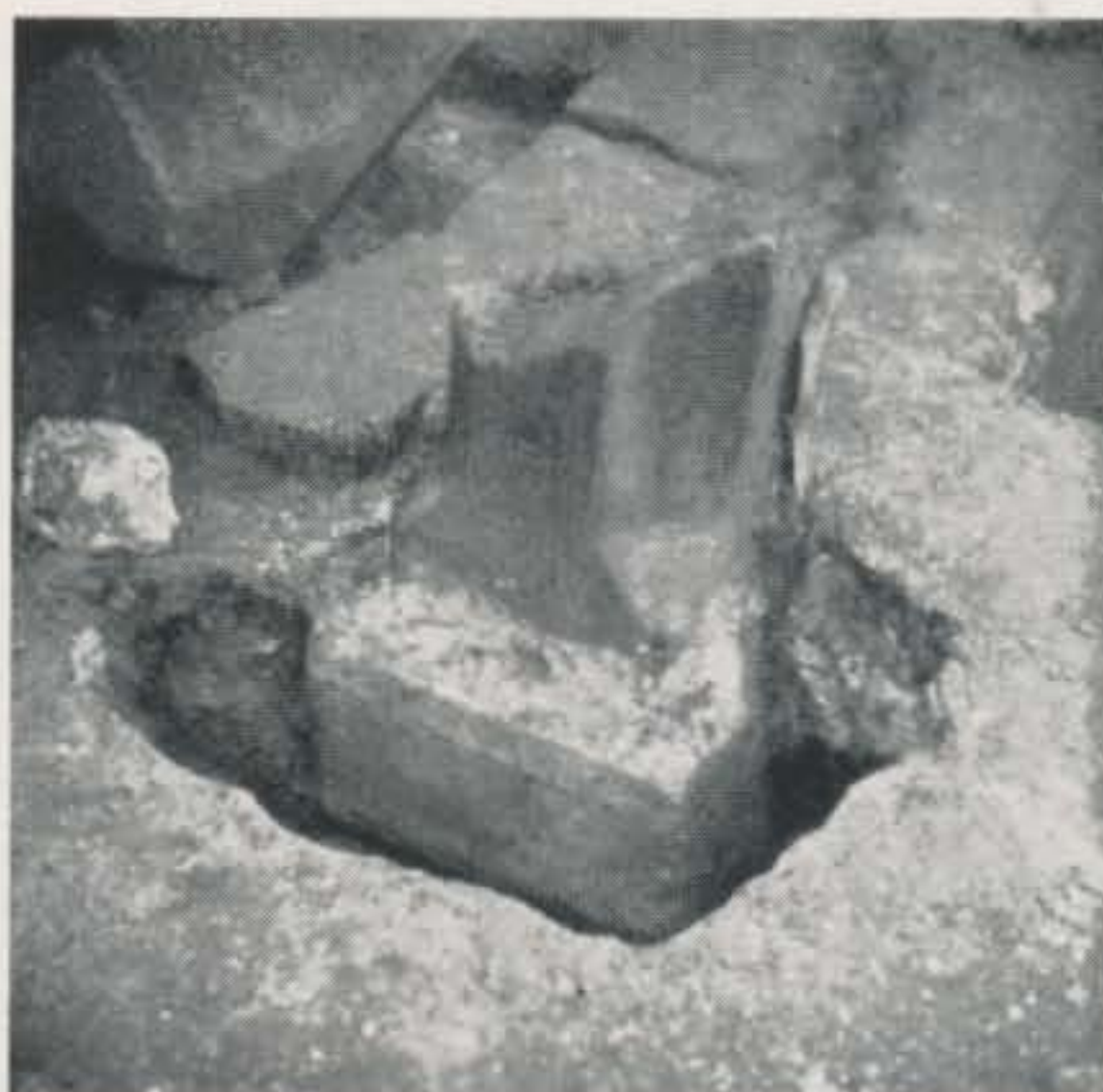
4. Mittelpfeiler bei B
