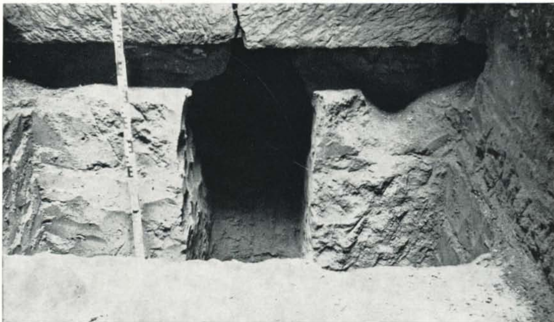
Freilegung eines auf Lößlehm gegründeten Fundamenteiles am Kattenburg-Ostflügel. Wie der Stichstollen unter dem Fundament erwies, sind in diesem Bereich von dem einstigen Holzrost nur leere Kanäle übriggeblieben, so daß die Gründungsfläche sehr bedenklich vermindert wurde. Höhe der Mauerwerks-Unterkante: 142,70 m über NN.
