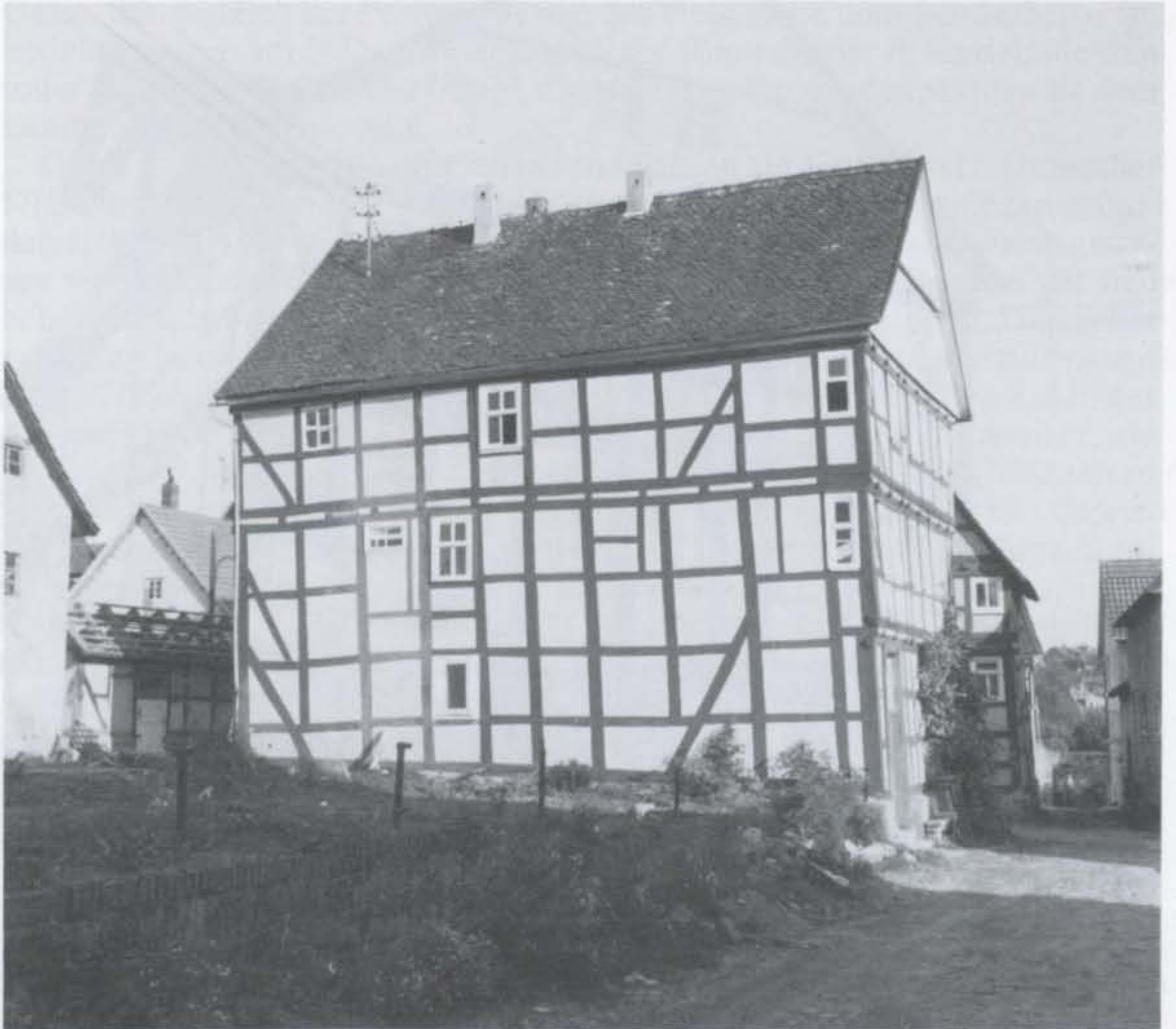
Abb. 2: Seitenansicht der Metropolanei zu Neukirchen (mit Pfarrgarten).
