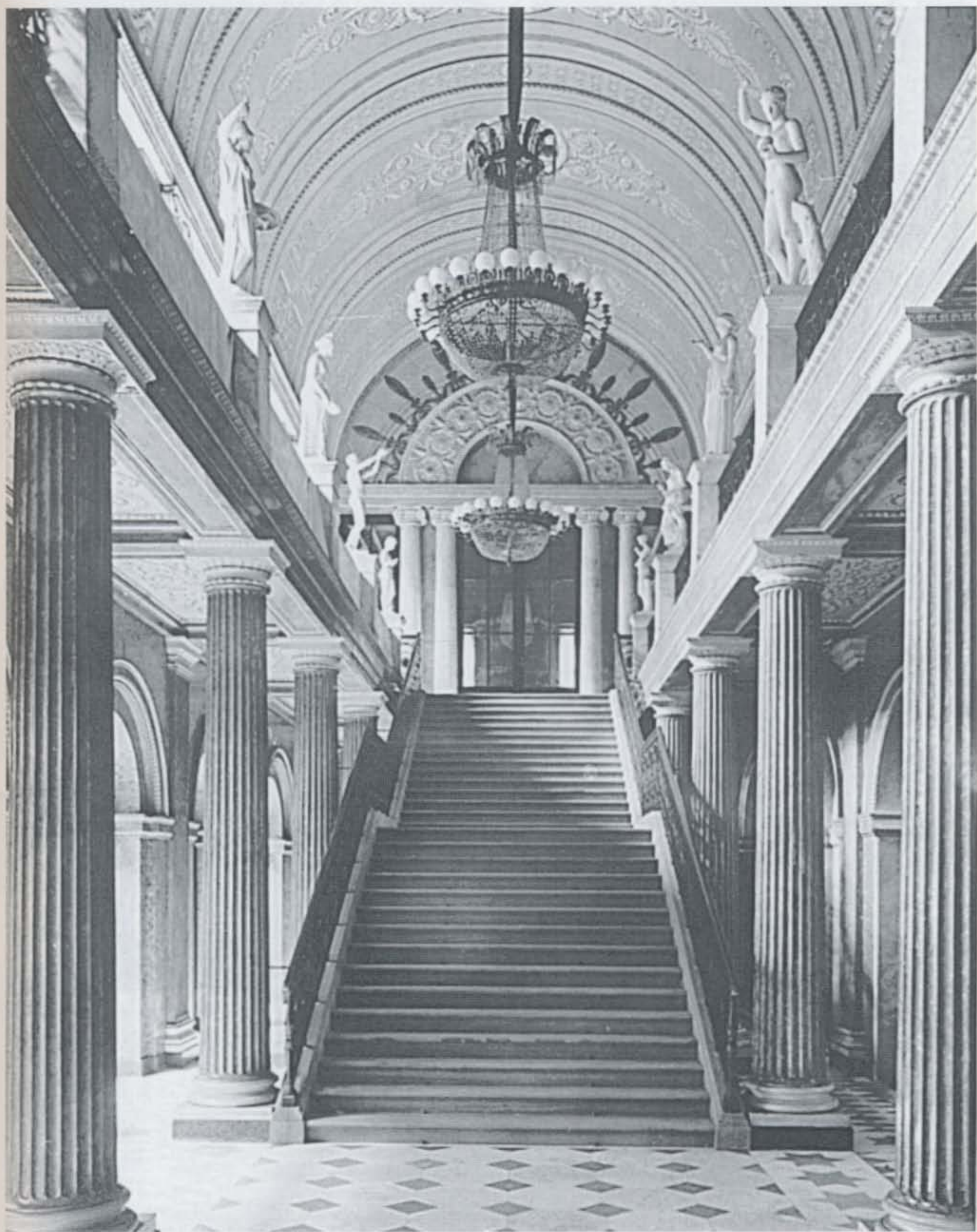
Kassel, Treppenhaus Residenzpalais Bildarchiv Foto Marburg KBB 12.492
