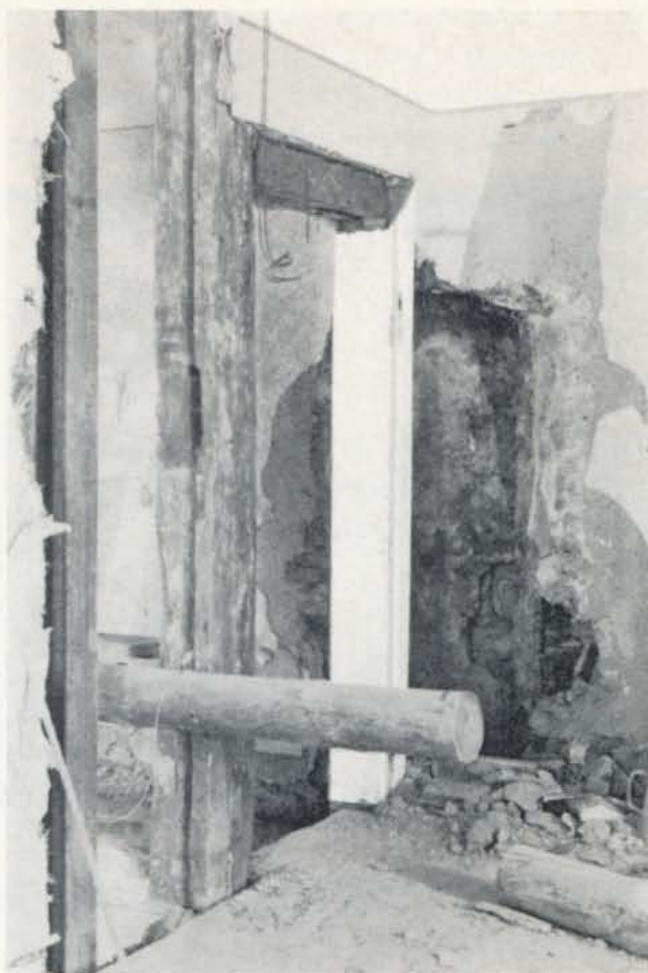
Abb. 9 Hauptbau, Türe des 19. Jh. und Ausgang der Wendeltreppe im ersten Obergeschoß (Raum während des Umbaus)
