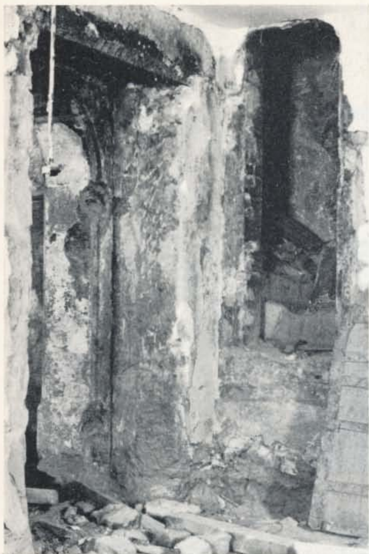
Abb. 8 Hauptbau, spätgotischer Zugang zu Raum 3 und unterer Zugang zur kleinen Wendel- treppe (während des Umbaus)
