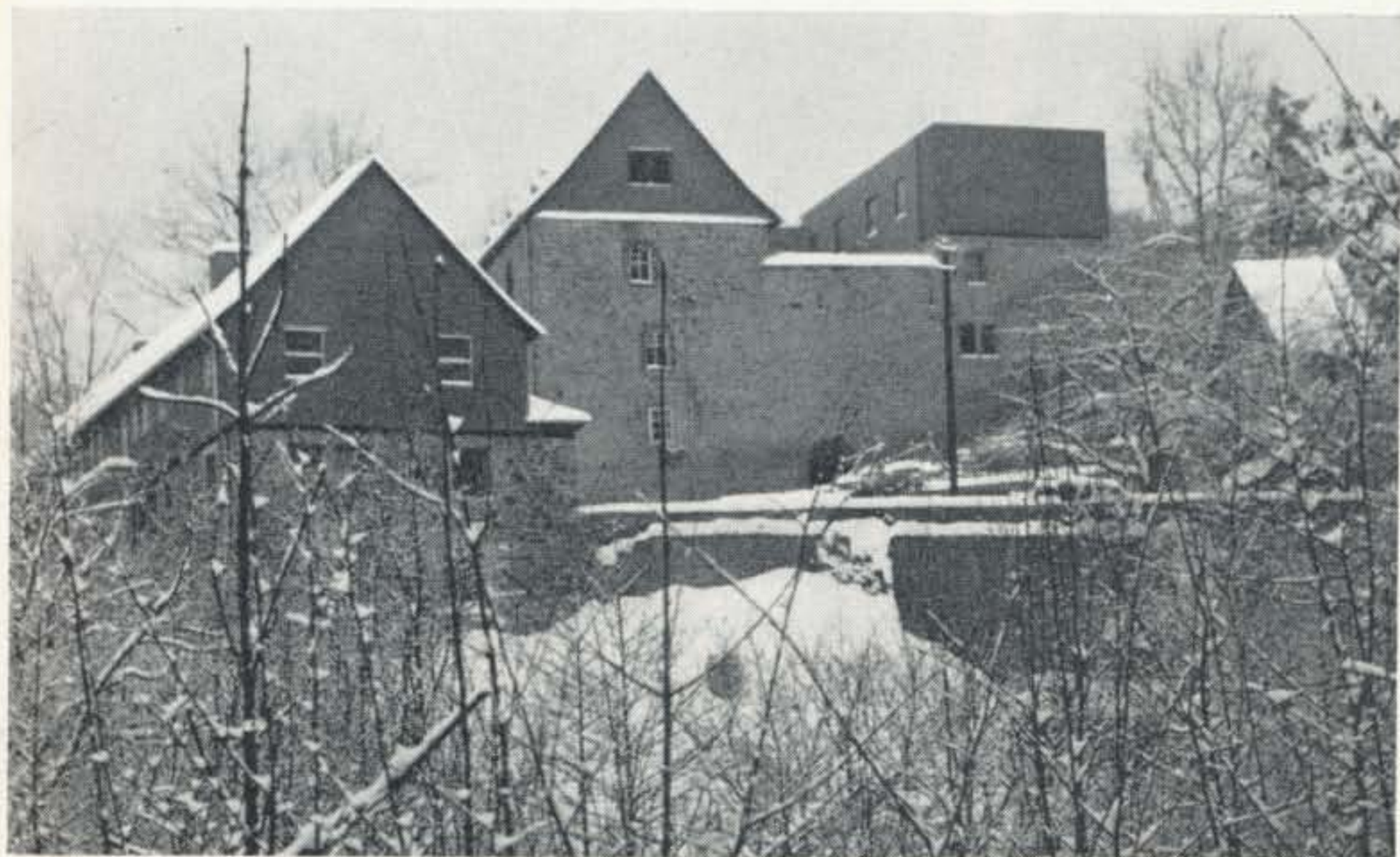
Abb. 2 Hessenstein, Gesamtansicht von Süden nach dem Umbau (Winter 1969/70).
